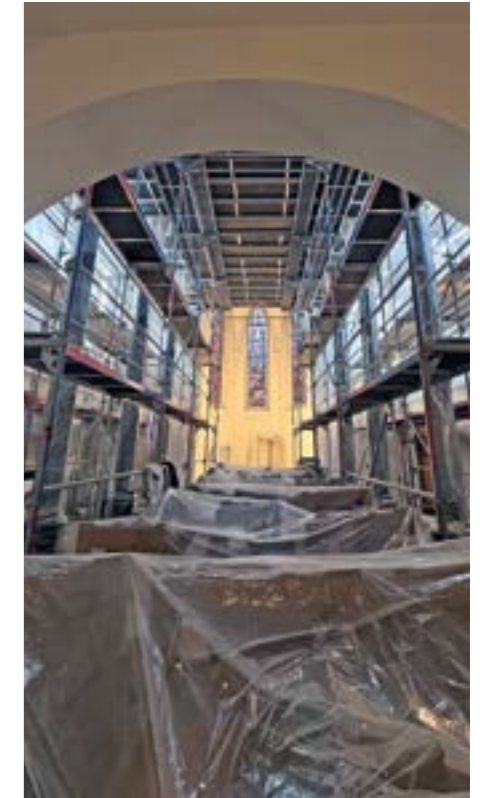
Die Kapelle während der Umbaumaßnahmen
